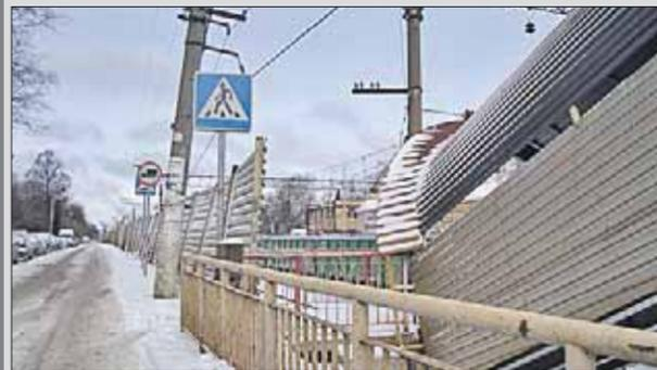
Жители Сходни пожаловались в Госадмтехнадзор по поводу своего перрона. Шумозащитное ограждение опасно покосилось в сторону железнодорожных путей. Неровен час, оно упадёт на рельсы. Инспекторы выехали на место и зафиксировали нарушение.
