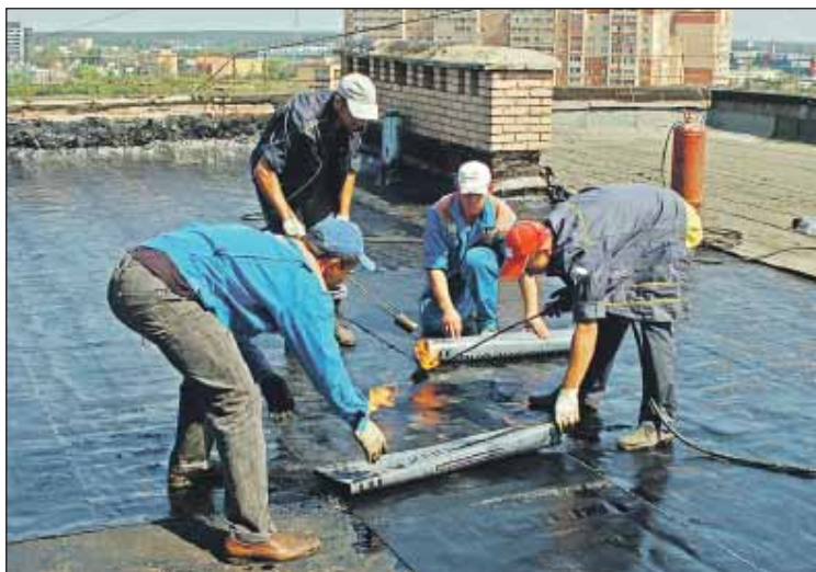
Работы на крыше дома 21, корпус 3, по Олимпийскому проспекту
