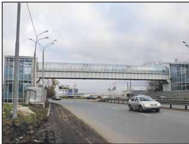
Успели достроить только корпус перехода
