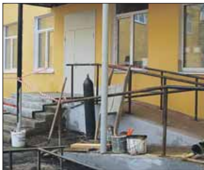
У школы №8 завершается строительство пандусов
