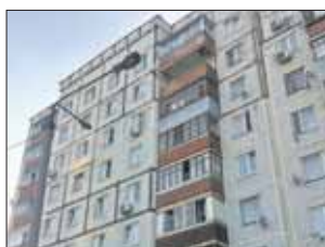
Межпанельные швы загерметизируют полимерной штукатуркой
