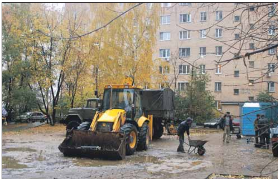
Идёт строительство детской площадки на Олимпийском проспекте, 36, корп. 4
