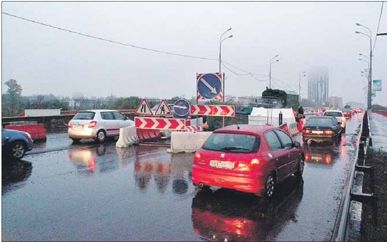
Работы на мосту на Олимпийском проспекте затрудняют движение
