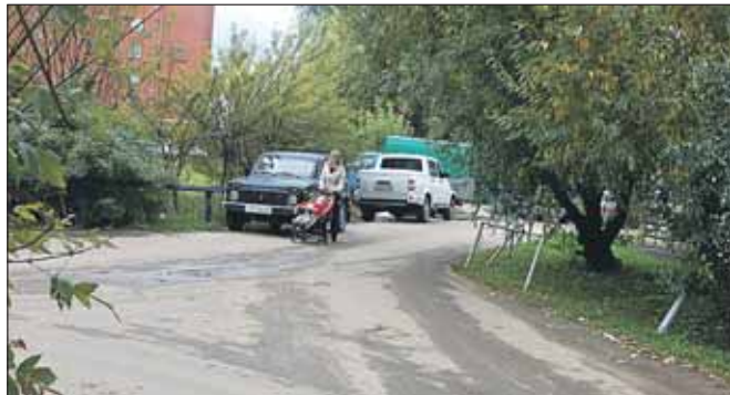
Асфальт на улице Юбилейной, 35, корпус 2, уже отремонтировали
