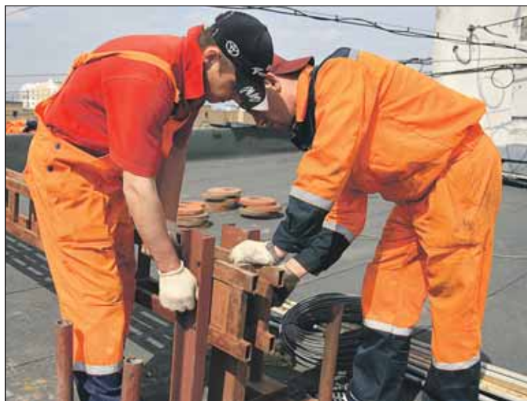
Крыши домов ремонтировали всё лето
